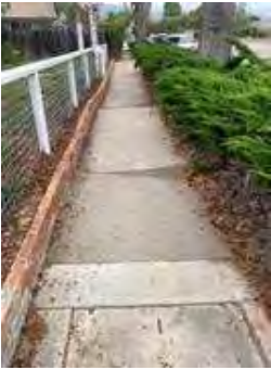
Hazard 33: 5483 Cameo Rd
