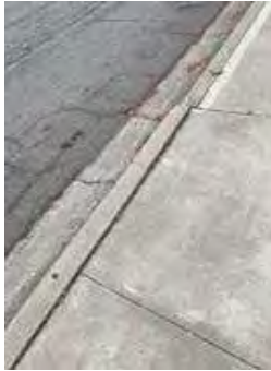
Hazard 37: 5048 El Carro Ln C^sw
