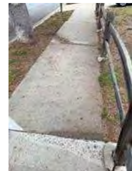
Hazard 27: 5436 El Carro Ln
