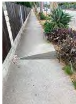
Hazard 17: 5497 Granada Way
