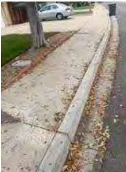
Hazard 19: 5404 Granada Way
