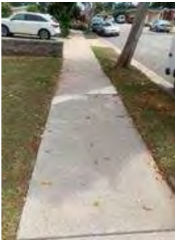
Hazard 4: 1484 Andrea St
