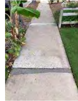
Hazard 34: 5359 Ogan Rd
