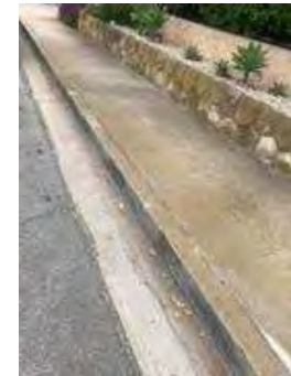
Hazard 6: 1368 El Portal AveSw^c
