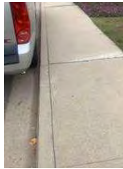
Hazard 14: 5450 Granada Way Sw^c
