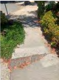
Hazard 2: 1478 Alva St
