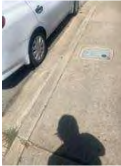
Hazard 1: 5021 Alvarado Rd C^sw
