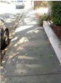
Hazard 3: 1369 El Portal Ave
