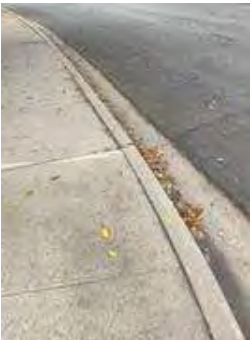
Hazard 21: 5404 Granada Way C^sw
