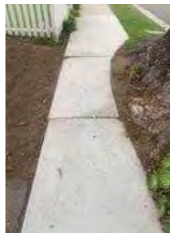
Hazard 8: 1334 Camino Trillado
